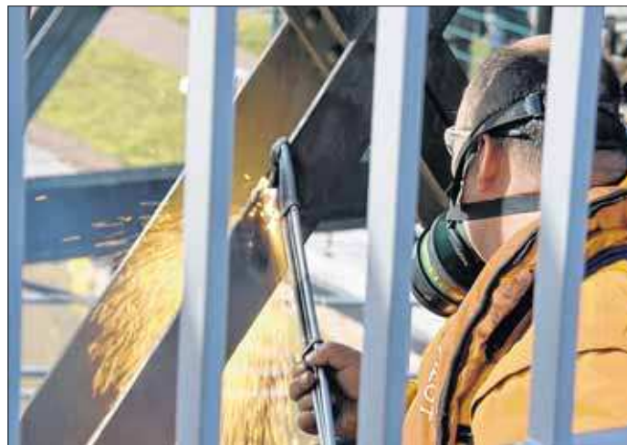
Mittels Schweißgerät wurde die Kanalbrücke in zwei Hälften geteilt. Zwei Kräne hielten das Bauwerk auf Spannung
