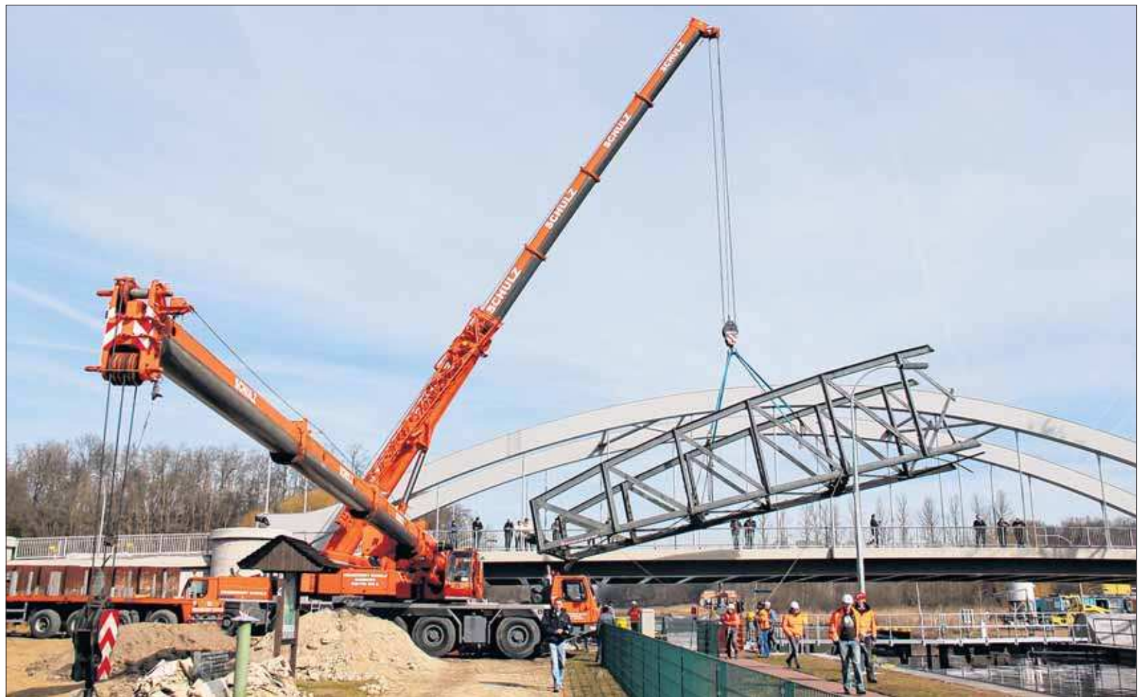
Ein 250-Tonnen-Kran schwenkte gestern kurz vor 11 Uhr die abgetrennte Brückenhälfte auf die westliche Seite des Elbe-Lübeck-Kanals.
