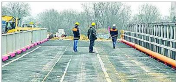
Bauarbeiter inspizieren den Zustand und die Lage der Brücke in Lauenburg über den Elbe-Lübeck-Kanal.
