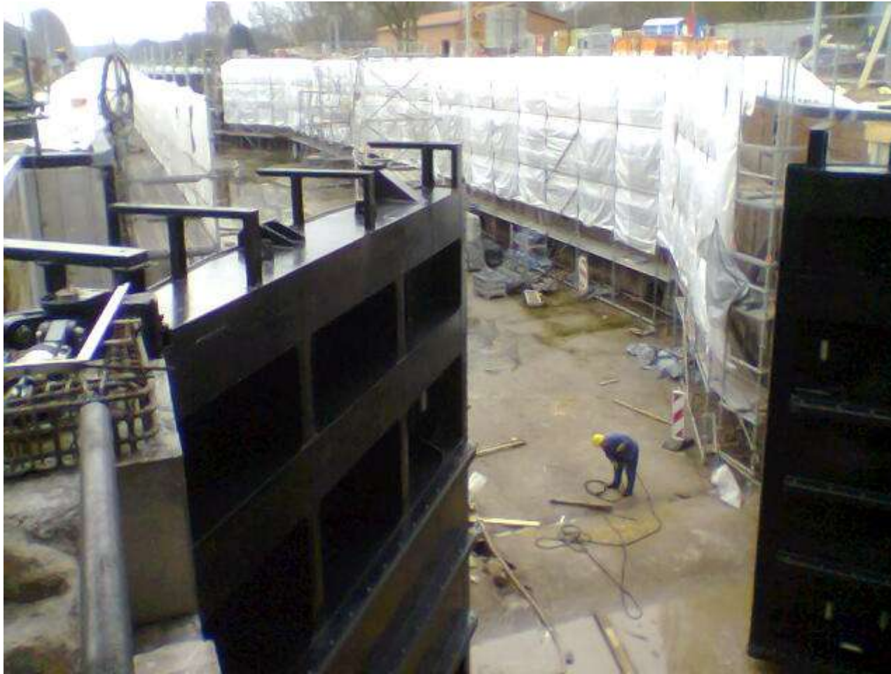
Das neue Stemmtor wird angebracht (April 2006)
