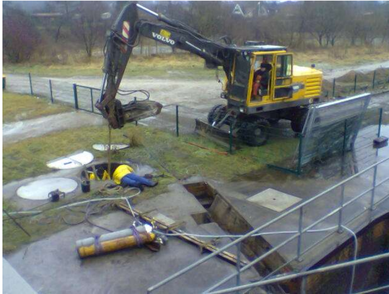
Heben der Tauchglocke (Februar 2006)
