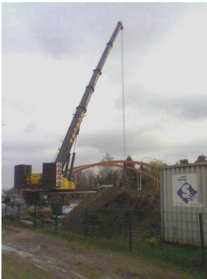
Ein schwerer Autokran hält das neue Stemmtor (April 2006)
