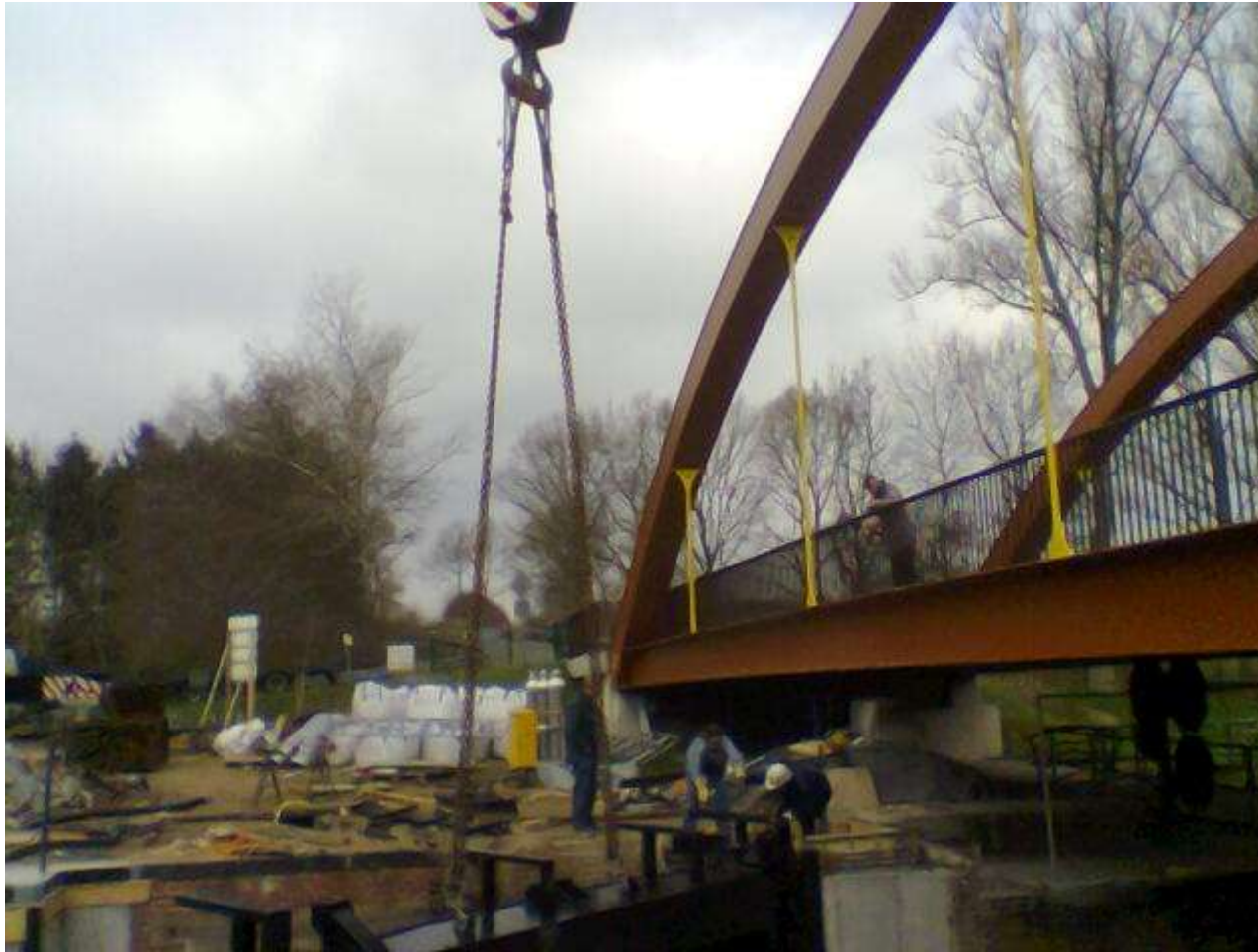
Das neue Stemmtor wird angebracht (April 2006)
