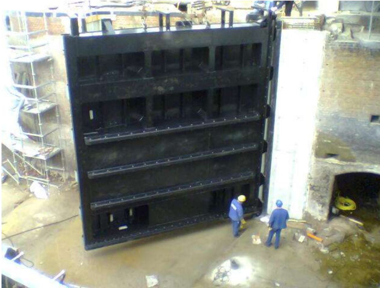
Das neue Stemmtor wird angebracht (April 2006)
