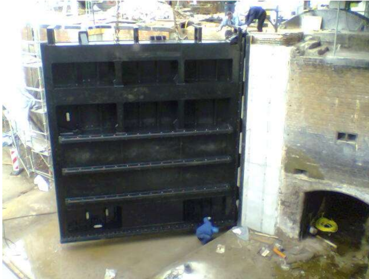
Das neue Stemmtor wird angebracht (April 2006)
