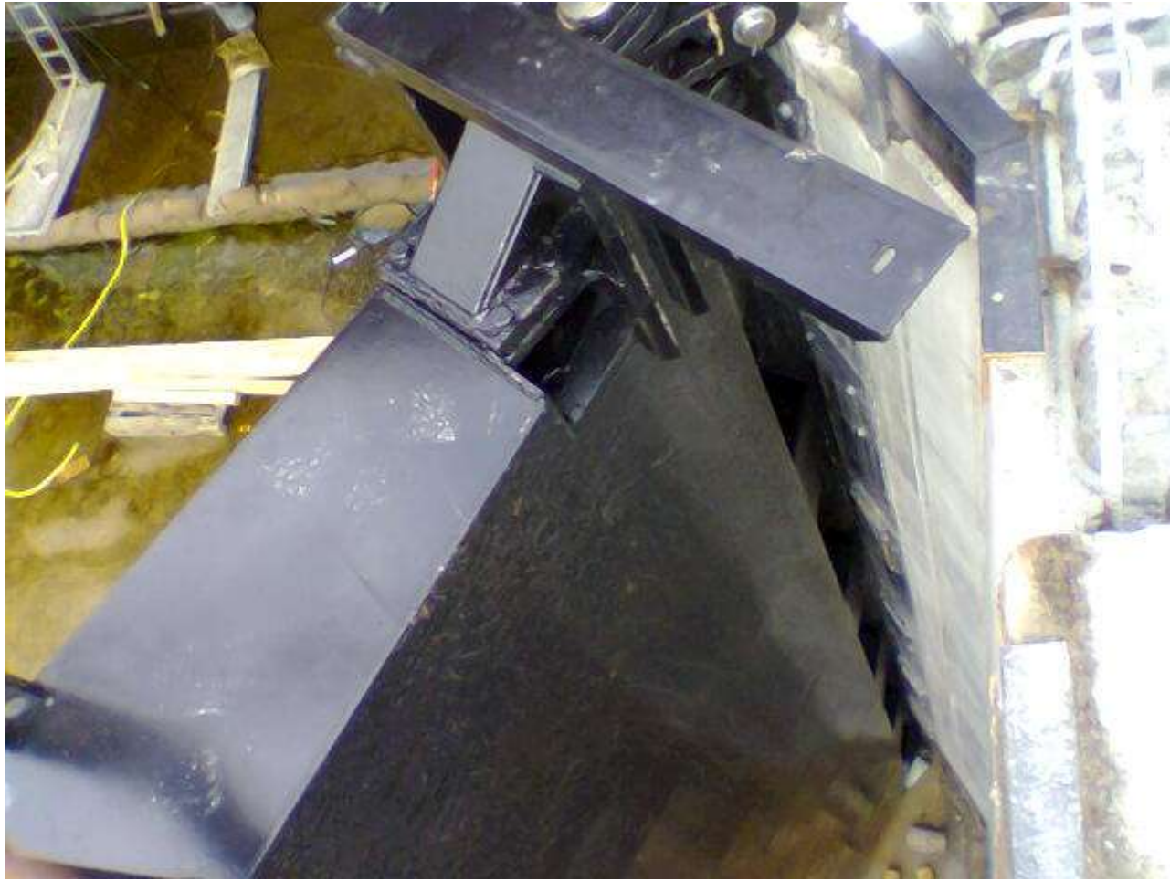
Das neue Stemmter wird angebracht (April 2006)
