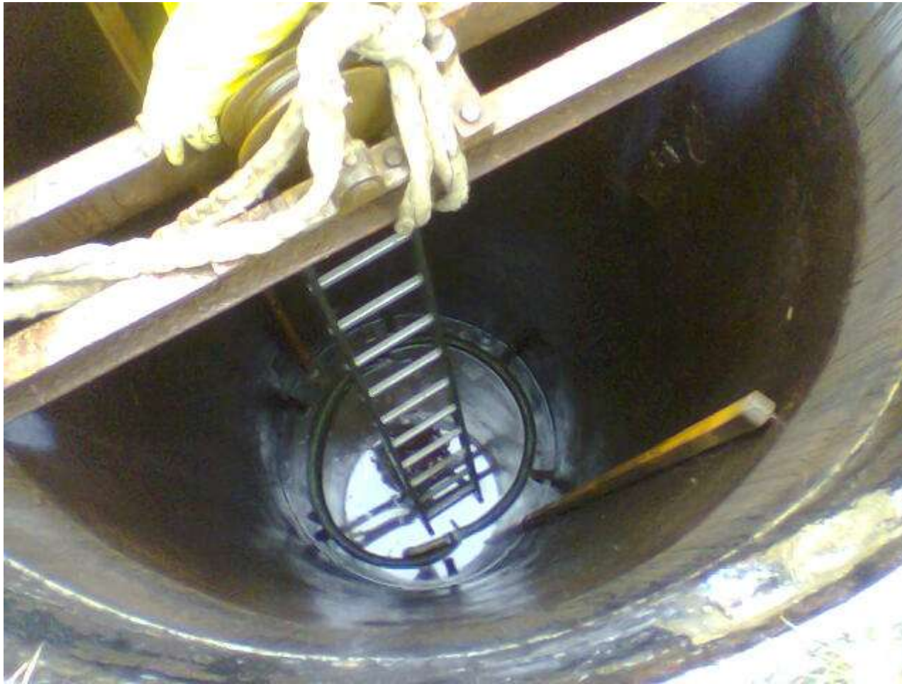
Der Brunnen mit Tauchglocke (Februar 2006)
